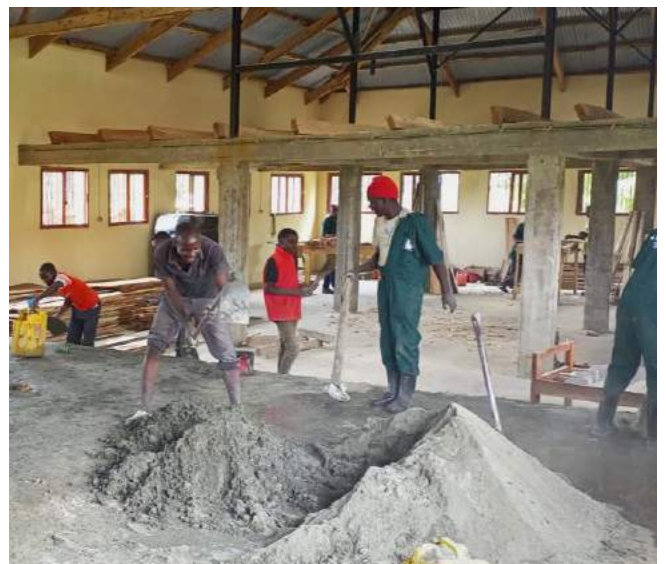
Bauarbeiter-schüler zementieren den Boden in unserer Tischlerei
